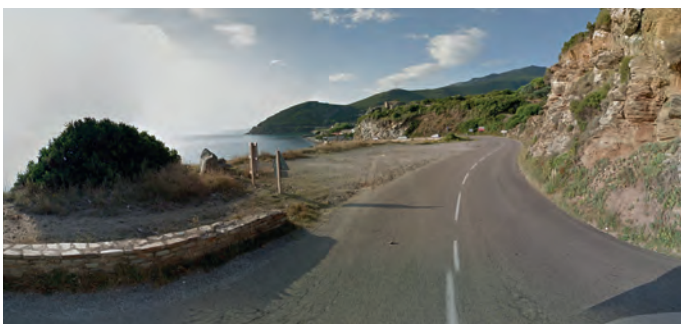
Exemple d'une surlargeur vue comme un délaissé.
