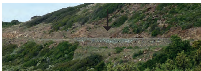
Mur de soutènement / talus végétalisé
