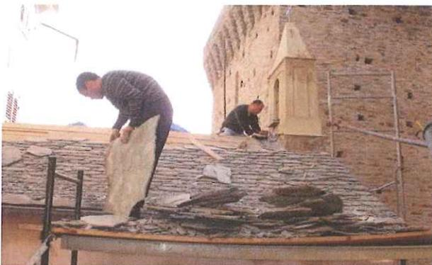
La restauration a été confiée à l'entreprise Nicolai de Bastia. Elle est en voie d'achèvement : réfection complète du toit (voûte et charpente reprises, pose de solins et de lauzes), décroûtage des murs et leur traitement à la chaux, pose d'un drain d'évacuation, réfection complète du sol en dalles de Gênes et cabochons de marbre blanc, reprise des boiseries ont été réalisés. Il reste à assurer la mise en couleurs de l'ensemble (semaine 18).
